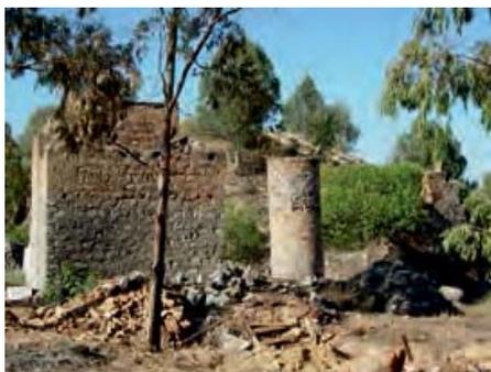
Este era un pozo para la extracción, situado algunos metros al norte de San Martín. Tiene unas paredes, a modo de inicio de cabria de mampostería, con contrafuertes. Junto a él se sitúa otro pozo auxiliar, de sección circular. Muy cercanas a él se encuentran las instalaciones del lavadero de flotación de EMITER (Explotaciones de Minas y Terreras, S. A.). Se encuentra entre el gran dique de estériles de flotación y el camino de Arrayanes. En esta zona hay gran cantidad de hundiciones.
