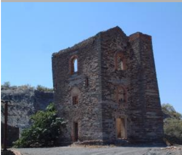
Casa Cornish en Alcaracejos (Córdoba)
