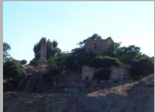
Conjunto Cornish en la Mina San Gabriel Lavaderos de Mineral
