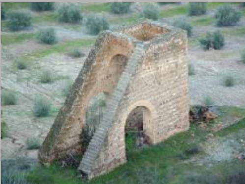
Cabria de Mampostería en la Mina El Calvario Fundiciones
