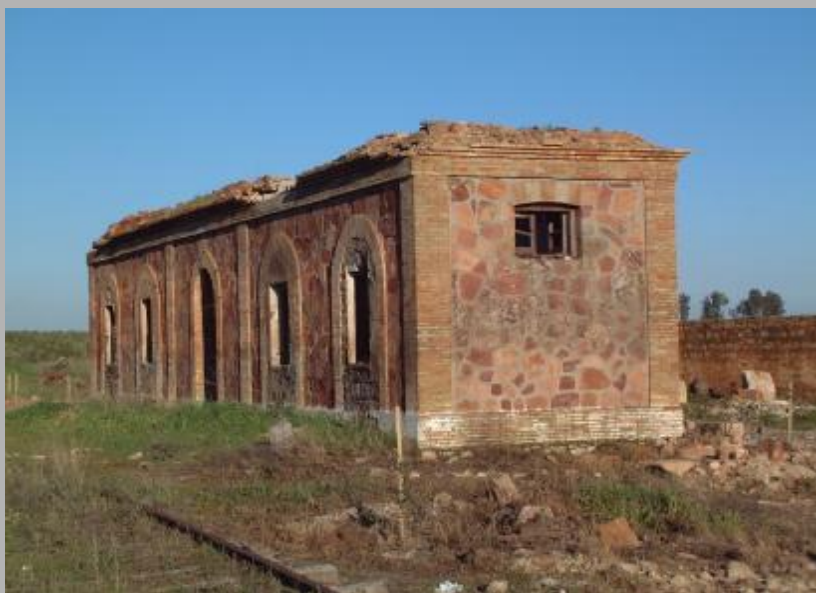
Estación de Pozo Ancho en la línea Linares - Los Salidos
