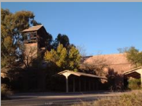
Instalaciones de la Fundición La Cruz
