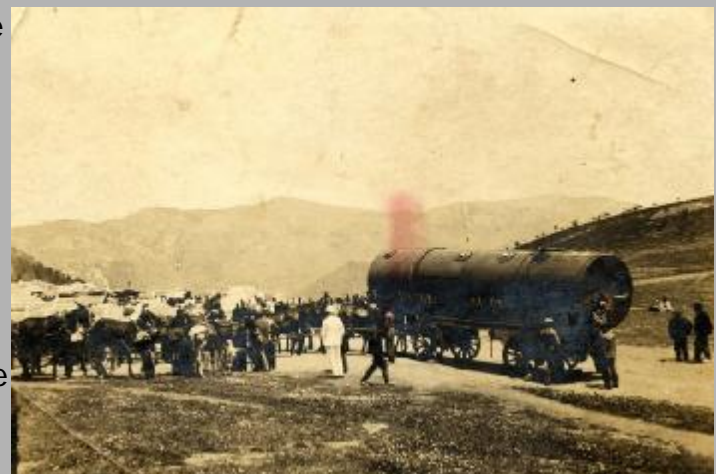
Transporte de caldera en El Centenillo (Baños de la Encina)
